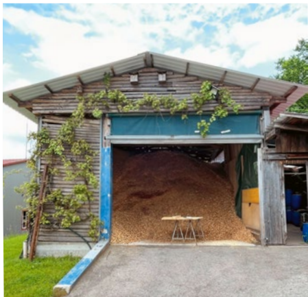
Abb. 1: Seit 2007 wird eine nachhaltige Holzschmelzheizung betrieben. (© O+W)
